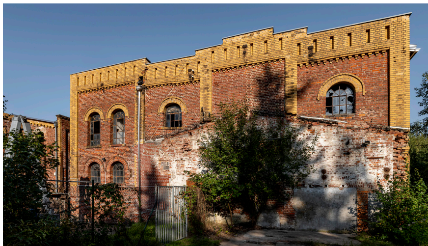
Gelände des ehemaligen VEB Papierfabrik Wolkenburg
